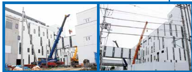
[6月25日] 入院治療棟(写真左の左側・北西側から撮影)と陽子線治療センター(右側)をつなぐ渡り廊下は外装が終わりました。写真右は南側から撮影。
